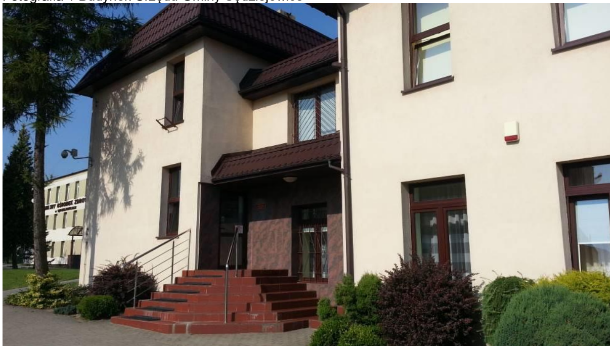
Fotografia 1 Budynek Urzędu Gminy Sędziejowice
