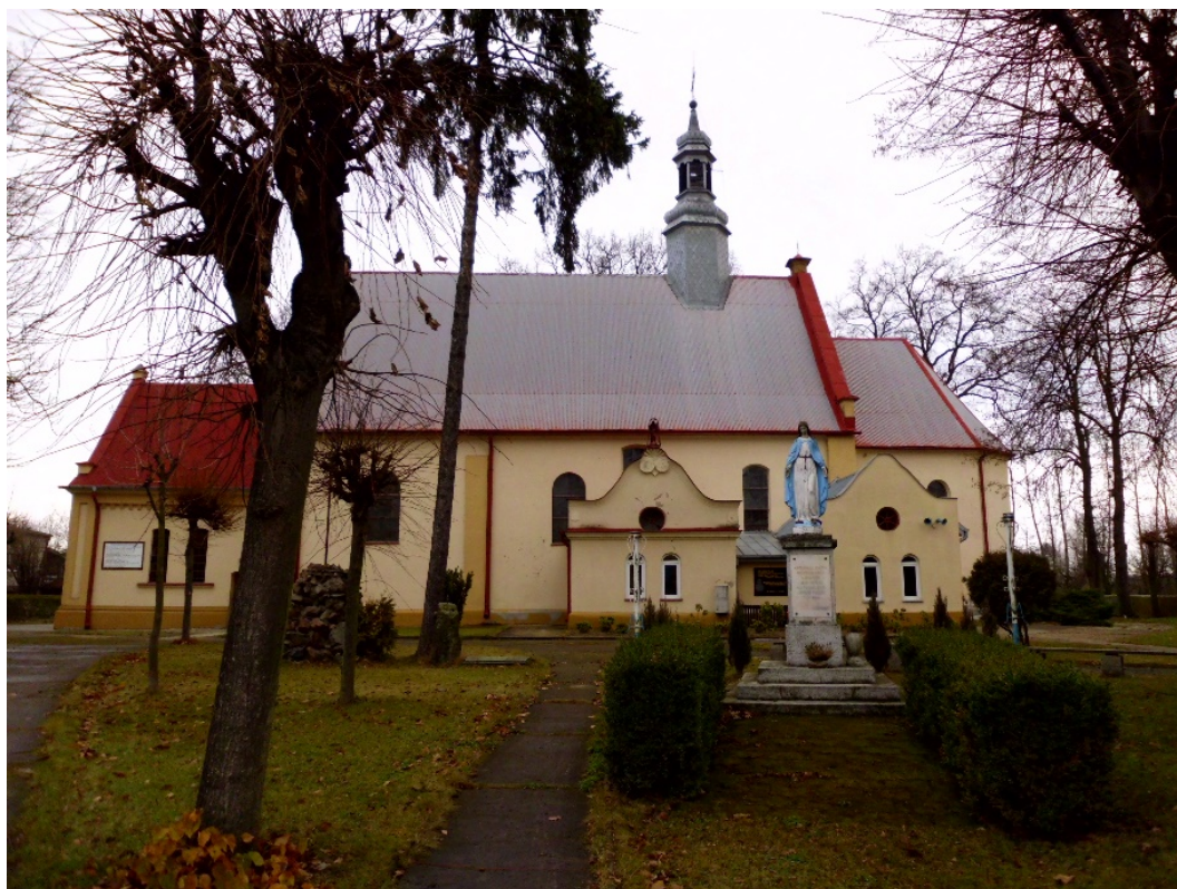
Kościół parafialny w Marzeninie pw. Wniebowzięcia NMP wybudowany w latach 1370 – 1372
