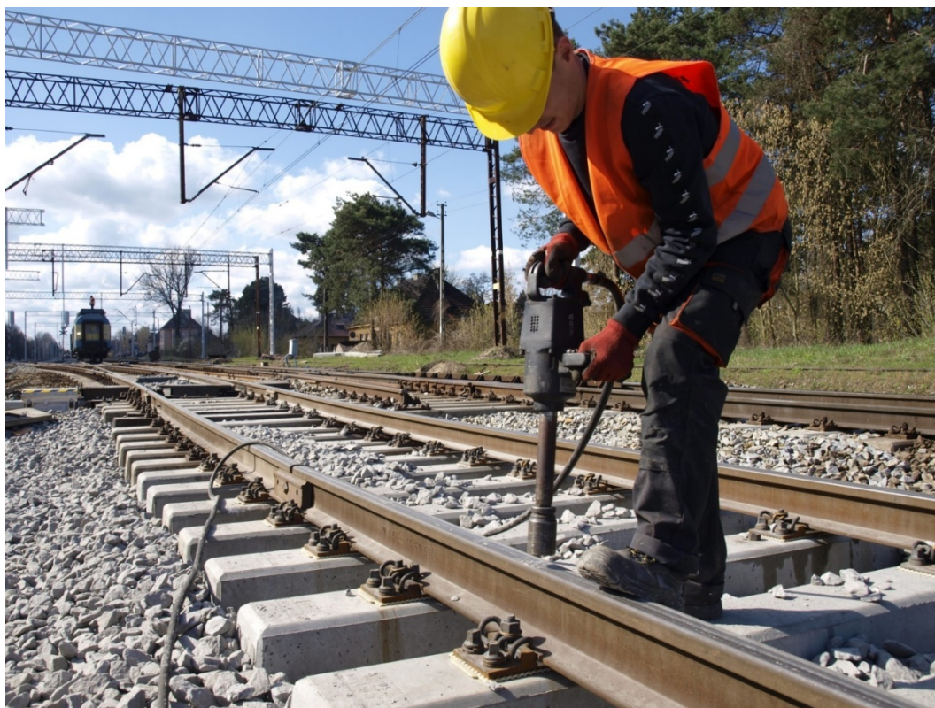
Prace modernizacyjne w okolicach stacji PKP Kozuby
