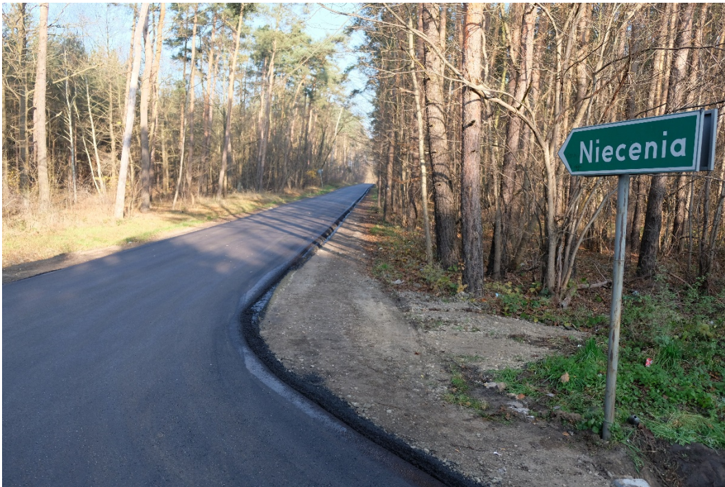
Remont drogi gminnej w m. Niecenia
