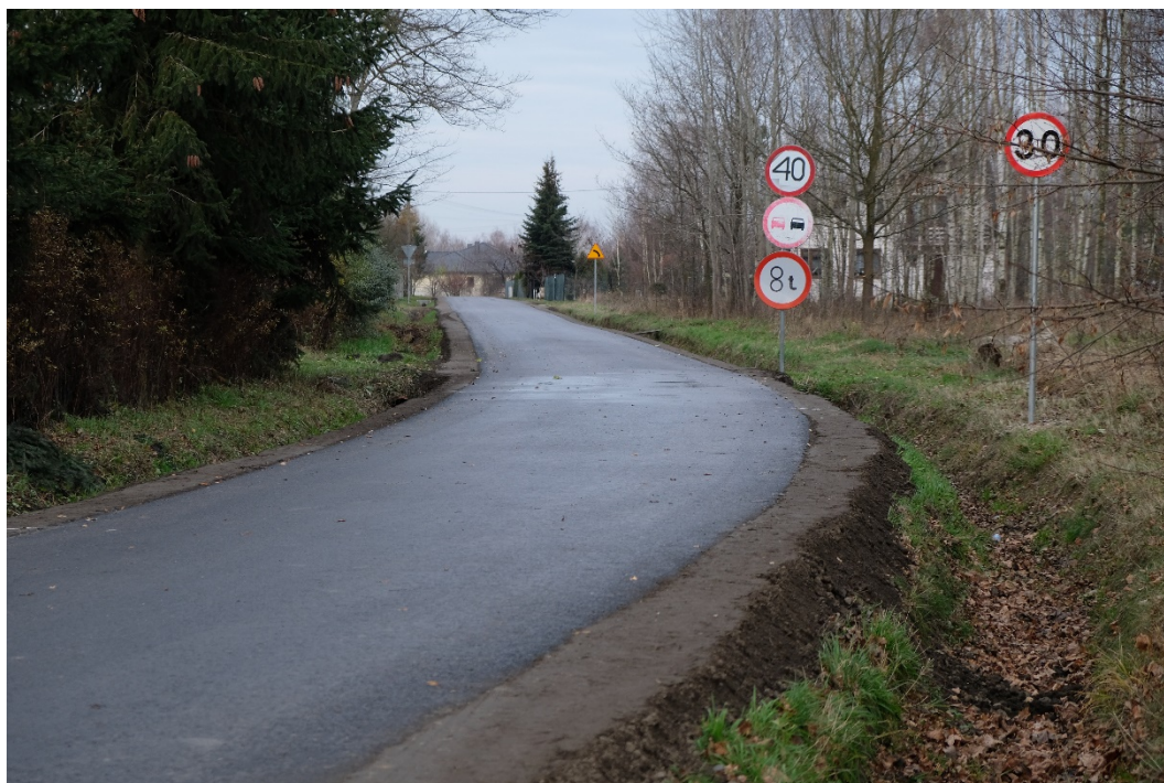
Remont ul. Źródlanej w m. Pruszków
