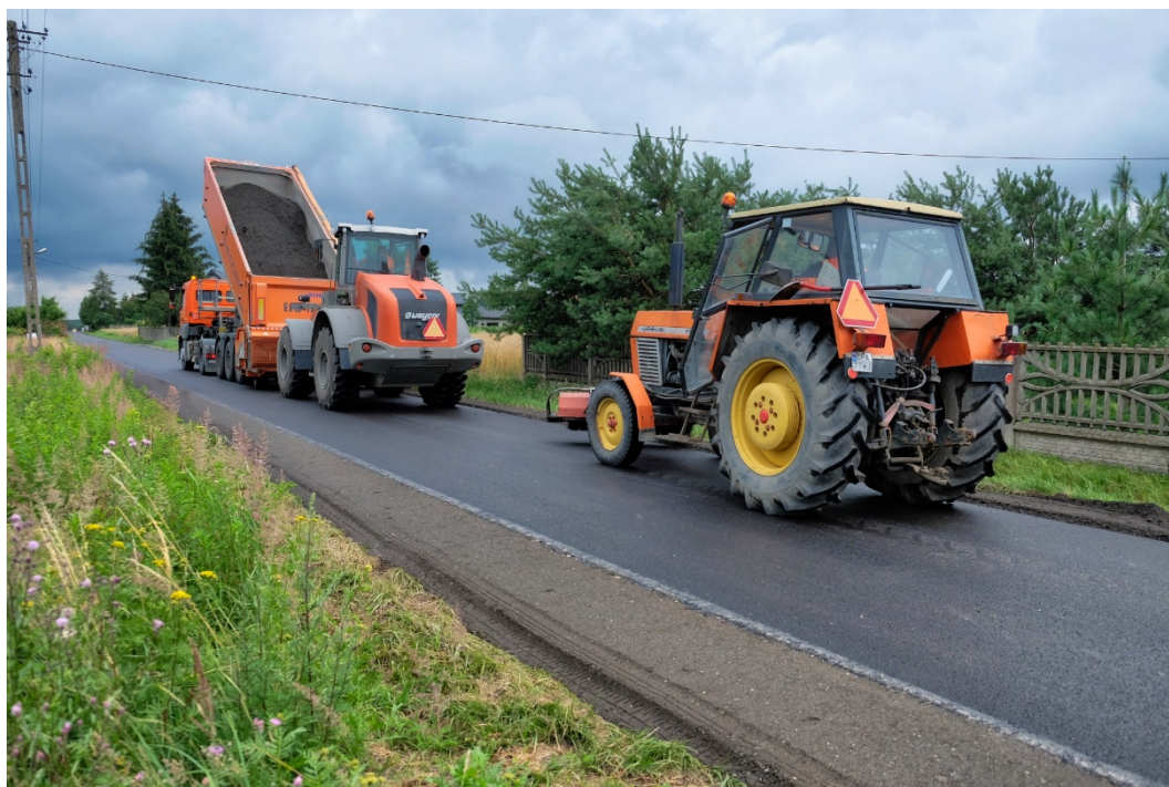
Remont drogi gminnej Nr 103052E Zduńska Wola – Bilew
