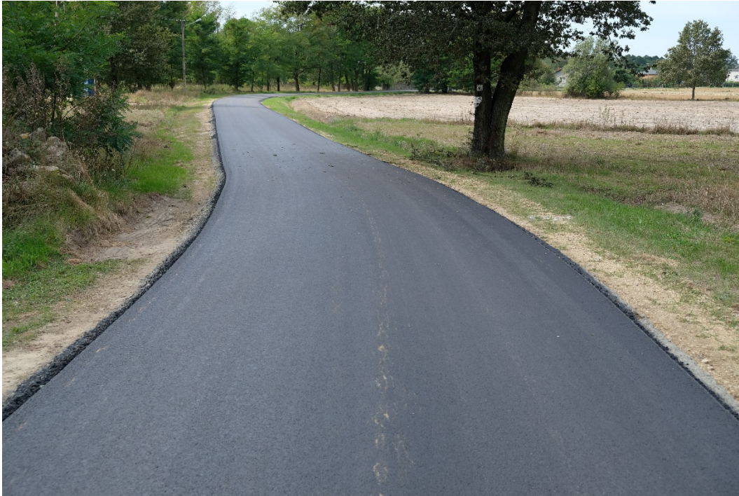
Remont drogi wewnętrznej dojazdowej w m. Wrzesiny
