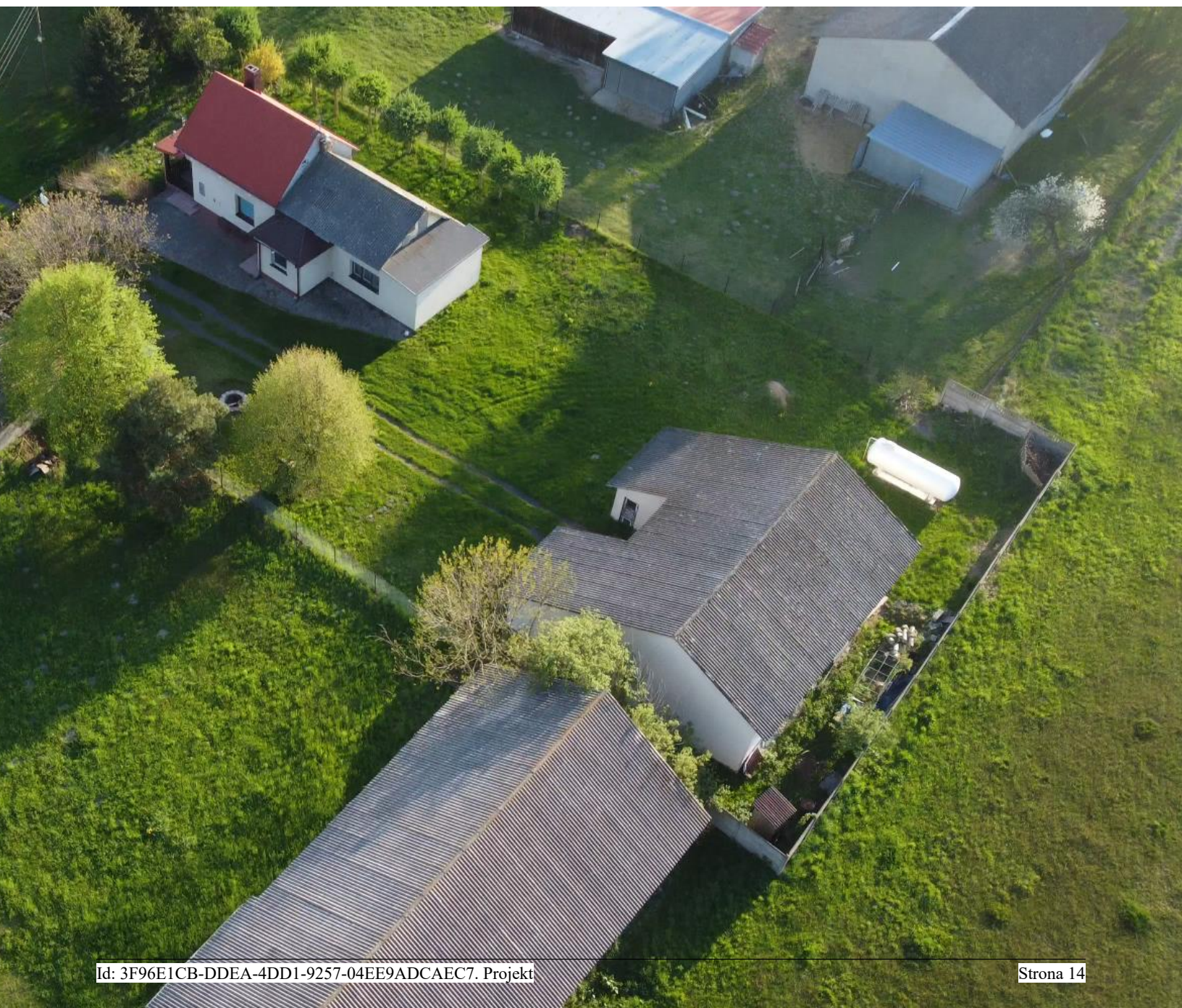
Fot. 1. Wykorzystanie wyrobów azbestowych jako pokrycia dachowe.
