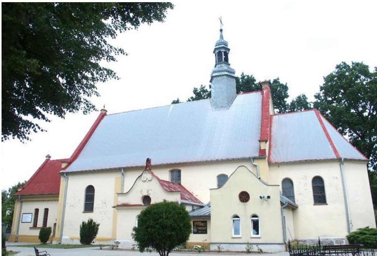
Rysunek 1 Kościół parafialny pw. Wniebowzięcia NMP w Marzeninie źródło: Strategia Rozwoju Gminy Sędziejowice na lata 2021-2026
