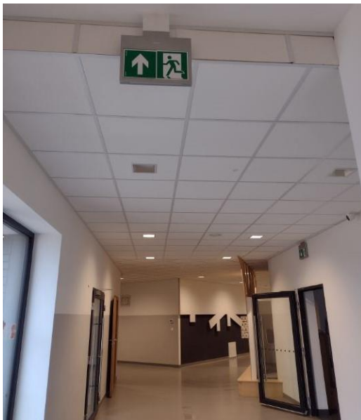
Rysunek 3. Sufity w ciągach komunikacyjnych przedszkola.
