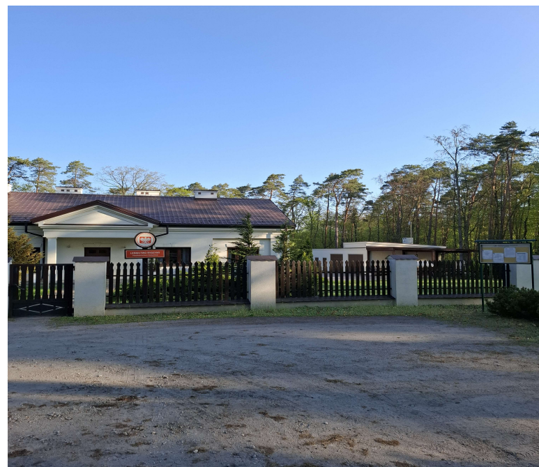
Fot. Budynek Leśniczówki Rydzyny wraz z infrastrukturą towarzyszącą
