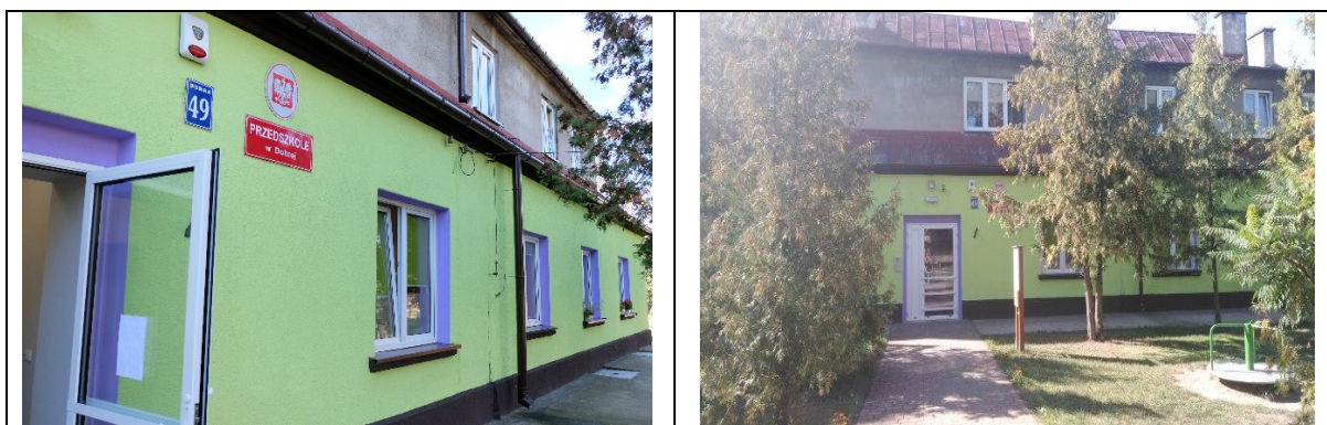
Budynek Przedszkola w Dobrej
