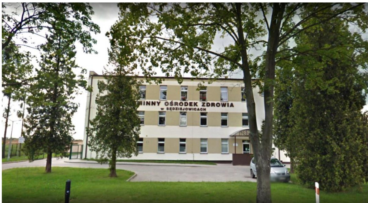
Budynek Gminnego Ośrodka Zdrowia w Sędziejowicach
